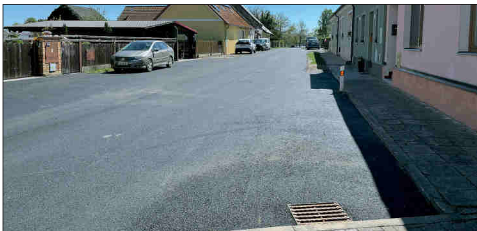
Šalounská ulice po opravě
