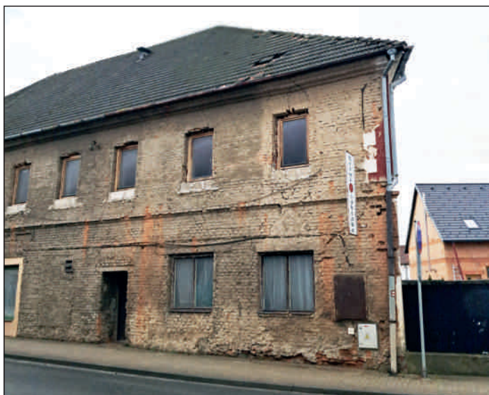
Neodtékající, ucpaný gajgr
