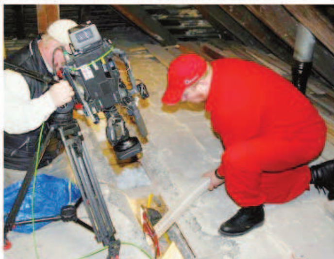
Při natáčení pořadu Rady ptáka Laskutáka – zateplení dutiny trámového stropu
