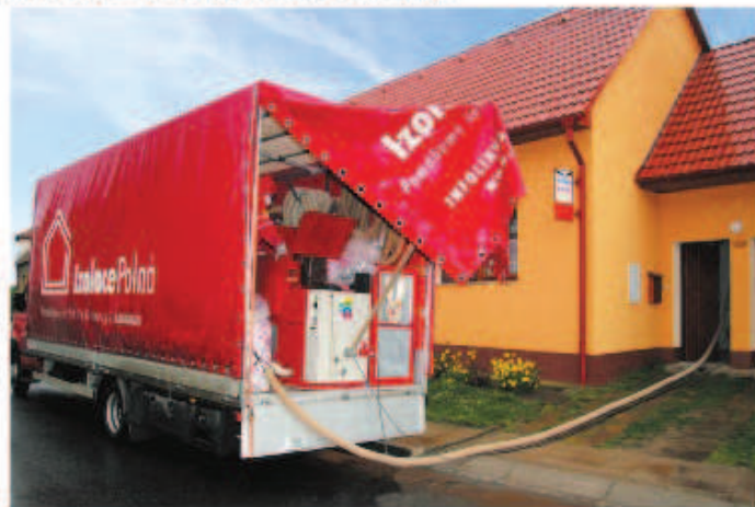
Foukání izolace hadicí z vozu před domem
