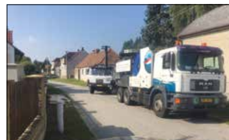
čištění kanalizace ve Školní ul.
