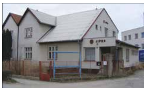
K porovnání takto budova vypadala před zahájením kompletní rekonstrukce zevnějšku a interiéru.
